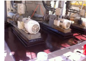
Reparación de anclajes
